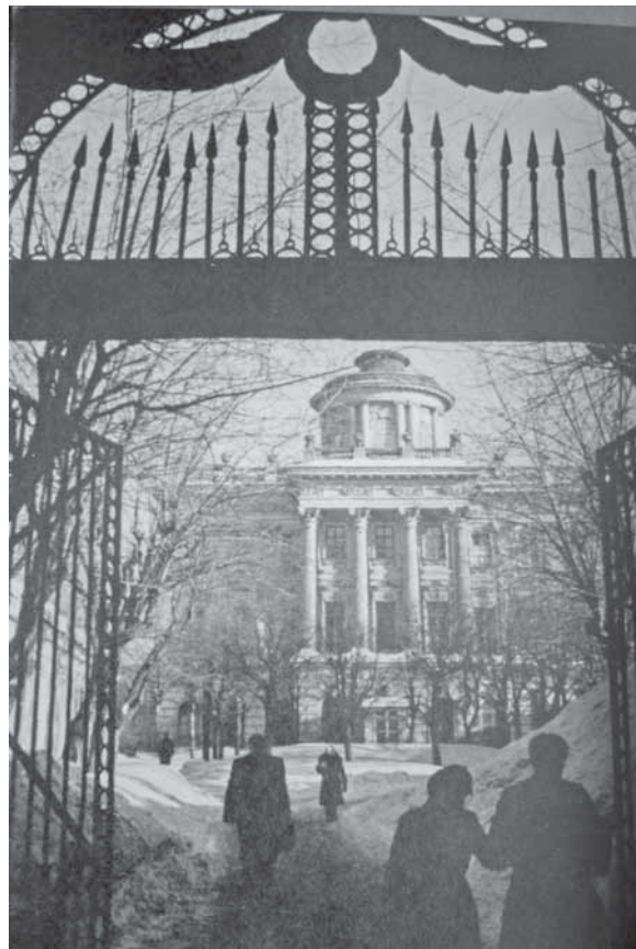
Пашков Дом. Главный вход в старое здание Библиотеки (фотография 1939 г.)
