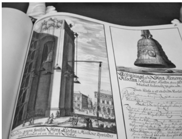
Устройство, при помощи которого был поднят большой колокол в Москве, а также вид части дворца. Рисунок знаменитого большого колокола в Москве, который был отлит в 1637 г. при царе Михаиле Федоровиче
